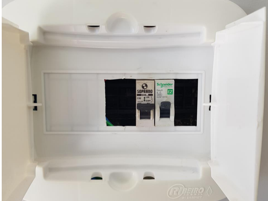
Foto 10– Quadro sala Reuniões – Fundos (externo) – 2º piso – Fonte Autor
