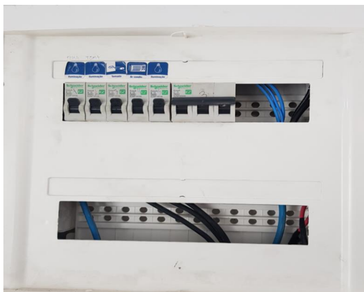
Foto 13 – Quadro 06 – Frente à esquerda de quem entra (externo) – 2º piso – Fonte Autor
